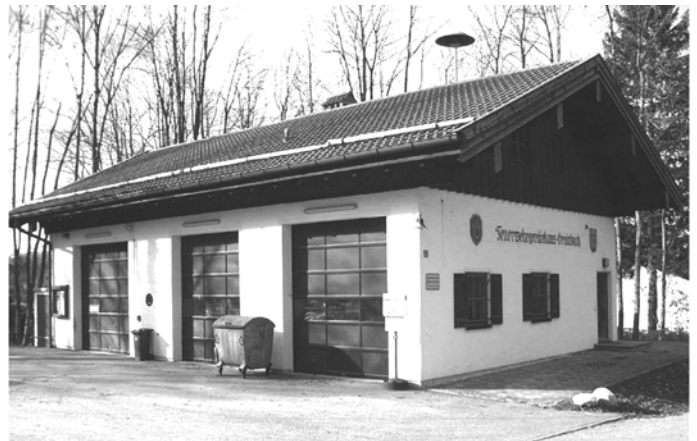
Das Obergeschoss des Grainbacher Feuerwehrhauses soll aufgestockt werden.
