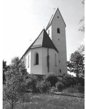
Die Außenfassade der Filialkirche in Grainbach wird heuer renoviert. Auch die Gemeinde beteiligt sich mit einem Zuschuss in Höhe von 3000 Euro.
