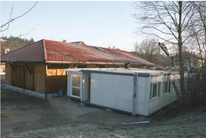
Mittlerweile ist die Containeranlage für die Kindergartengruppe Achenmühle komplett umgesetzt und aufgebaut
