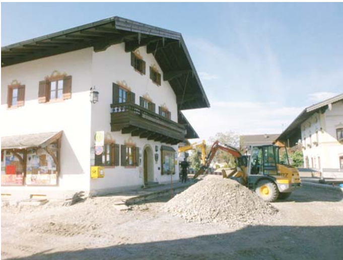
Baggerarbeiten vor dem Rathaus
