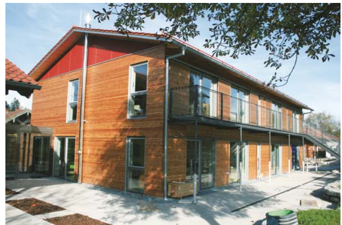
Die Treppenanlage aus Stahl für den zweiten Fluchtweg auf der Rückseite des neuen Gebäudes.
