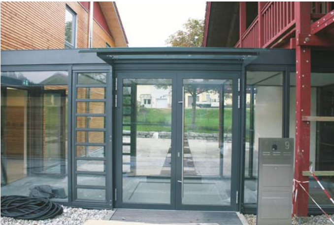
Neuer Haupteingang der „Zwergermühle“ ist der Verbindungsbau zwischen Alt- und Neubau.
