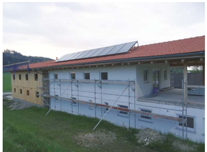
Der neue Bau kurz vor der Fertigstellung
