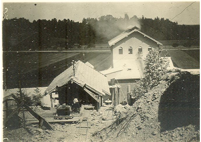
Das Gestein aus dem Steinbruch wurde mit Loren zum Brecher transportiert. Im Vordergrund das Brechergebäude, im Hintergrund das Ofenhaus, dort brannte man in den Anfängen das zerkleinerte Gestein zu Zementklinker. Foto im Besitz von Inge Warter
