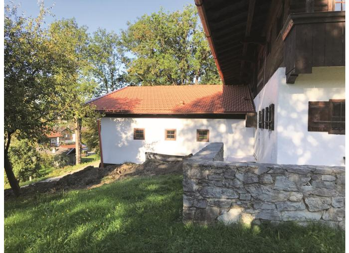
Die Anbau- und Umbauarbeiten am Achantaler Heimathaus sind jetzt weit fortgeschritten. Alle Rohbauarbeiten sind abgeschlossen, die Fenster gesetzt und die Wände verputzt. Von außen betrachtet könnte man meinen, der Anbau wäre fast fertig. In Kürze werden die Außenanlagen in Angriff genommen.
