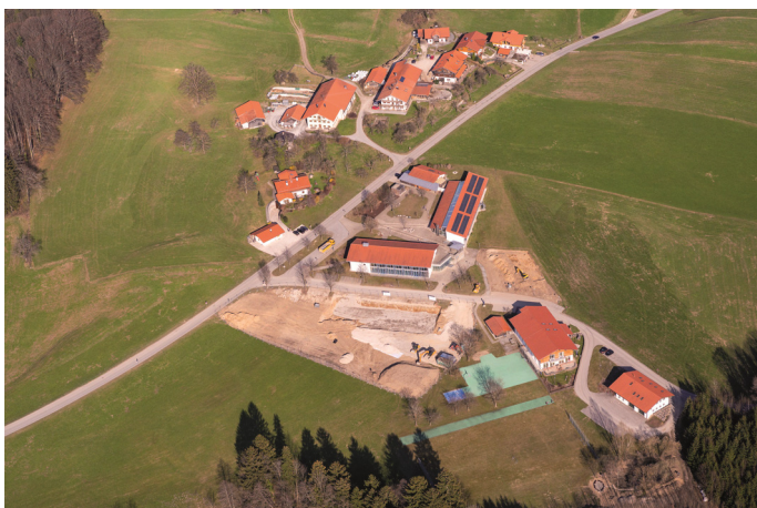
Der Kindergartenneubau schreitet zügig voran Foto: Rainer Nitzsche
