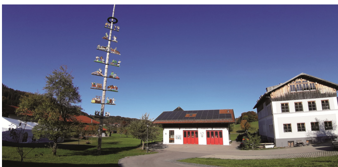
Das Feuerwehrhaus von Roßholz soll eine zusätzliche Garage bekommen. Dafür wird an der linken Seite ein Anbau errichtet.
